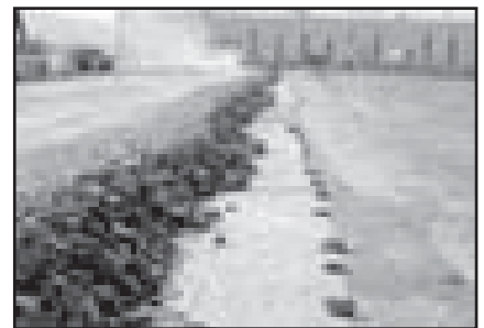
تقویت بستر جاده با استفاده از ژئوتکستایل
